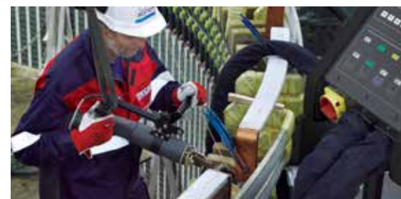
System ENRX Minac lutuje uzwojenia generatora. Dzięki mobilności Minaca i ręcznemu transformatorowi operatorzy mają dostęp do trudno dostępnych miejsc.
