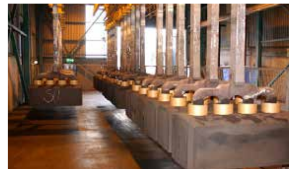
Brak pyłu, brak oparów, brak hałasu. Nagrzewnica ENRX z łatwością radzi sobie z trzpieniami anodowymi o średnicy 170 milimetrów.
