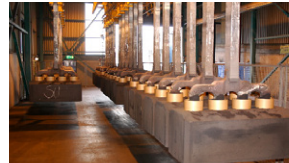
Kein Staub, keine Dämpfe, kein Lärm. Ein Induktionsgerät von ENRX erwärmt 170 Millimeter Anodenhalterungen..
