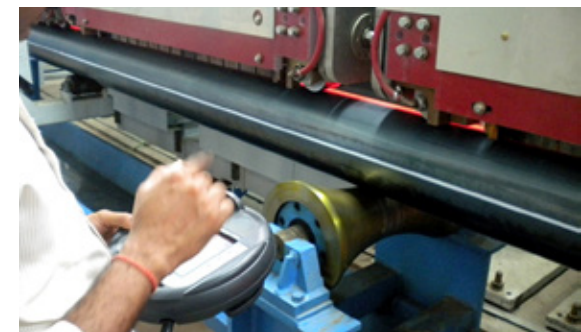
Die flexible Anlagensteuerung hilft dabei, die Herausforderungen beim Glühen von Schweißnähten an der neuen Generation von API-Standardrohren zu meistern.
